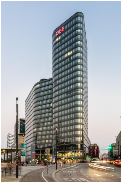
Die neue Unternehmenszentrale in der Außenansicht.
